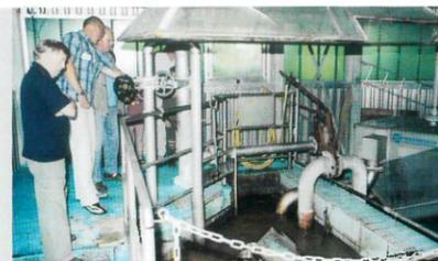
Das gesamte Abwasser von Neustadt, Pelzerhaken, Rettin und Altenkrempe durchläuft zu-erst diese Rechenanlage, in der alle groben Abwasserinhaltsstoffe zurückgehalten werden.
